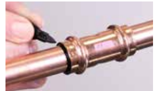
7b. Vaihtoehtoisesti voit työntää putken puristusosaan ja tehdä merkinnän.
