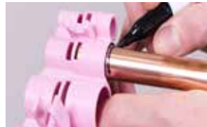
7a. Merkitse putkeen asennussyvyys syvyyssmitan avulla.
